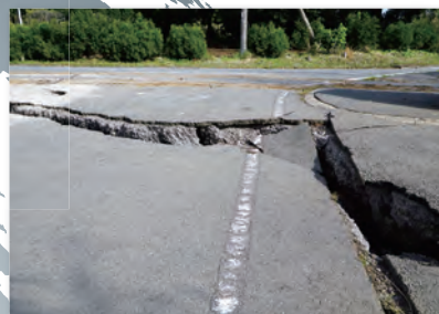
既存設備の老朽化対策
