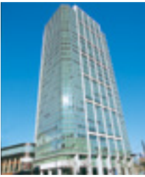
NBFプラチナタワー (東京都港区)
