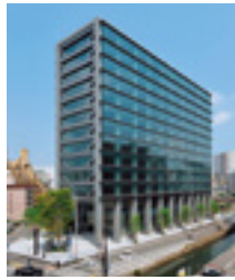
薬院ビジネスガーデン (福岡県福岡市)
